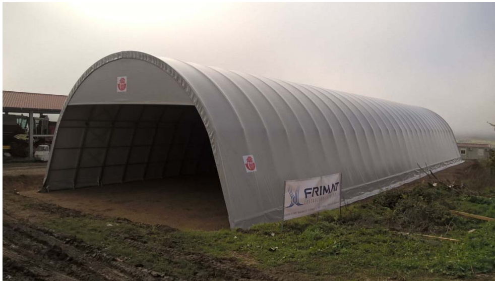
Foto 1: tunnel per Bovini da latte in costruzione (foto di G.Biasini)
